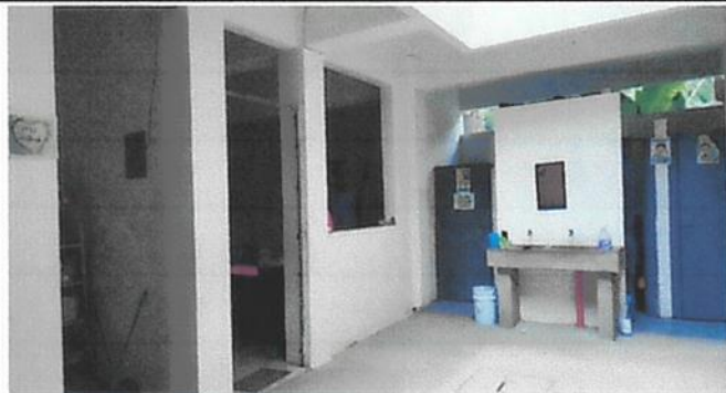
Foto1: Instalación de Azulejo en , baño y pared,
