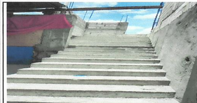
Foto 5: Instalación de piso antideslizante y baranda en gradas .
