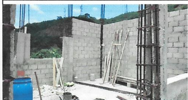
Foto 3: repello en paredes y sernido del segundo nivel
