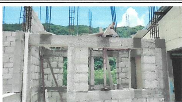
Foto 2: Instalación de Puertas y ventanas del segundo nivel.
