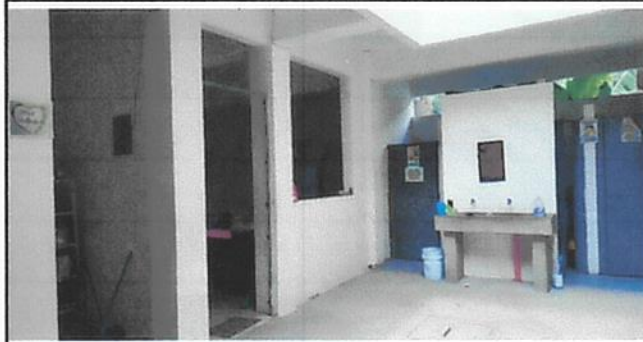
Foto 4: Instalación de puertas y ventanas en el aula del primer nivel.
