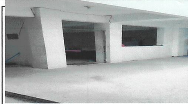
Foto 6: Pintura interiro y exterior en aula.
